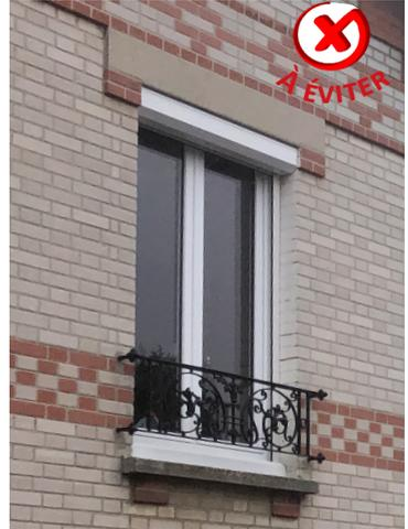
Le PVC est nocif pour la santé, non recyclable, se déforme avec le temps et crée des désordres (infiltration d'air et d'eau). Lors d'une rénovation, le remplacement des fenêtres en bois par le PVC appauvrit la façade ; Les petits-bois disparaissent et l'aspect initial de l'enveloppe du bâti est dénaturé. Cela rompt l'harmonie de l'ensemble.
