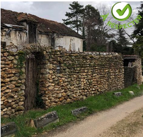
Les murs de clôture en pierre doivent être restaurés dans les règles de l'art - joints à la chaux avec des teintes harmonieuses avec les couleurs de la pierre.
