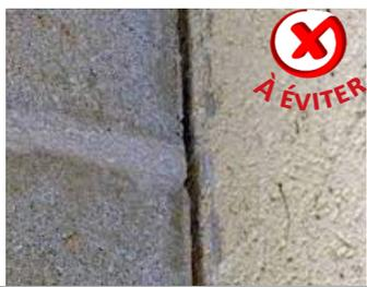
En mitoyenneté, manque de joint d'étanchéité et risque d'infiltration d'eau et de désordres.
