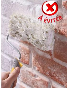
La peinture n'est pas adaptée sur un support en brique de terre cuite ou en pierre. Préférez l'enduit à la chaux si besoin de revêtement.
