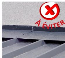
En toiture, la bande solin est non adaptée à la forme de la couverture (source qualiconstruction.com)
