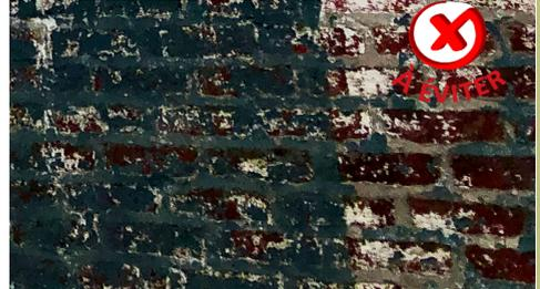
La peinture, le mortier et joints en ciment ne sont pas adaptés aux supports en matériaux naturels tels que la pierre et la terre cuite.
