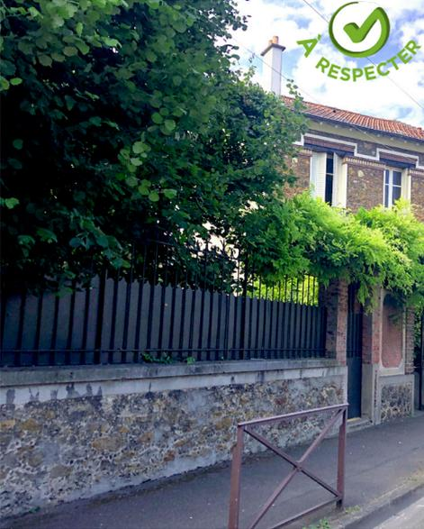
Rajouter une occultation en partie basse des barreaux - avec des matériaux et couleurs identiques - peut être une solution adéquate pour protéger de la vue et laisser un minimum de transparence afin de communiquer avec la rue.
