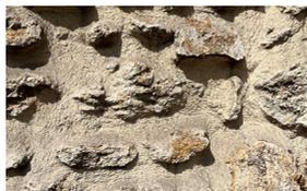
Enduit et joint au mortier de ciment, et imitation pierre, non adaptés.
