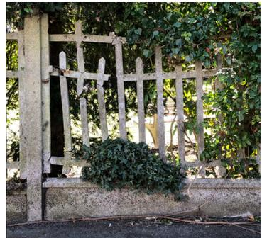
Les végétaux dont les racines ou les branches imposantes sont trop près des clôtures et les éléments techniques encastrés ultérieurement, peuvent fragiliser et endommager le béton.
