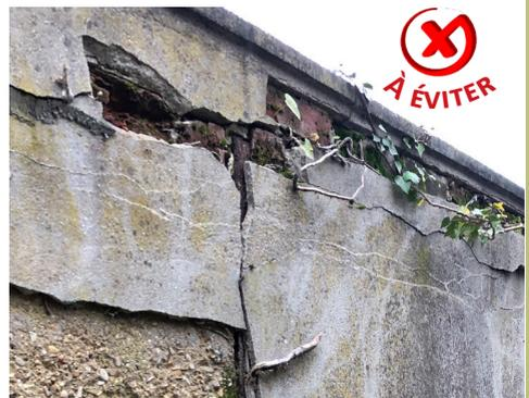
L'enduit béton sur un mur de clôture en brique et en pierre est inadapté.
